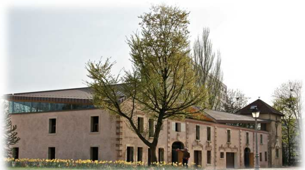
Réhabilitation de l'ancienne ferme du Charmois à Vandœuvre-lès-Nancy (54)
