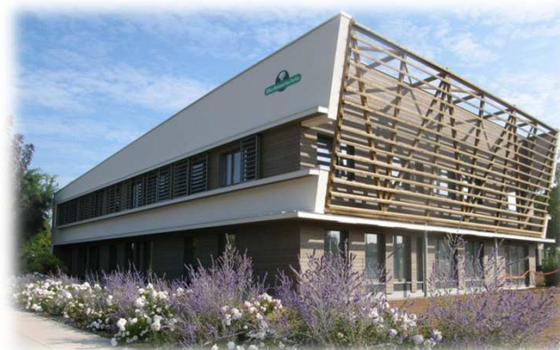
Réhabilitation de l'Agence de l'Office National des Forêts (ONF) à Metz (57)
